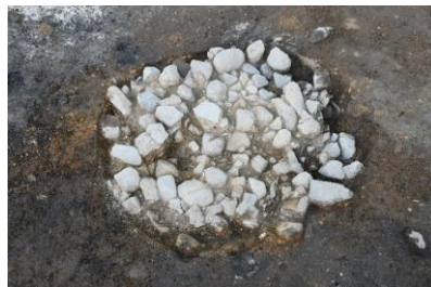
写真4 本丸御殿の坪地業（穴の内部に礫を充填している。右は礎石が残っていた例。）
