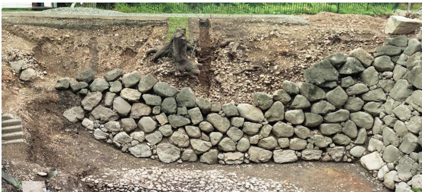
写真1 本丸と馬出を結ぶ土橋南側法面の石垣
