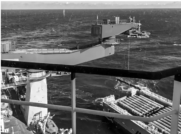
ロシアの天然ガスパイプライン「ノルドストリーム2」の建設現場（2019年9月、バルト海）=ロイター
